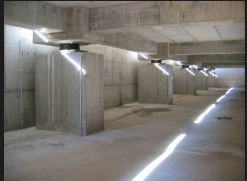
L'ala nuova dell'ospedale Gervasutta in costruzione a Udine (52 HDRB – primo ospedale isolato in Italia)
