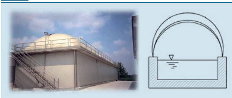
Fig. 2.2 Impianto semplificato con copertura a cupola
