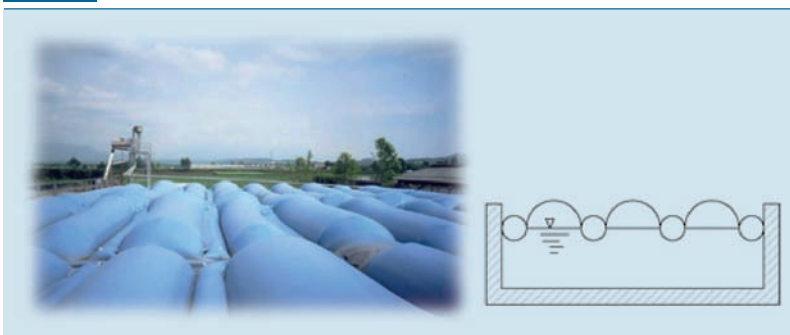
Fig. 2.3 Copertura gasometrica galleggiante
