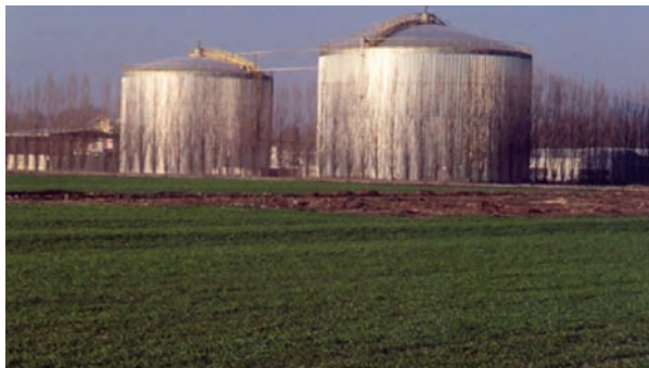
Figura 2.4 Impianto centralizzato a doppio stadio, Spilamberto (MO)
