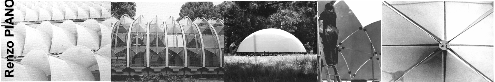
Lucernari di poliestere rinforzato: Padiglione IBM, 1982.
