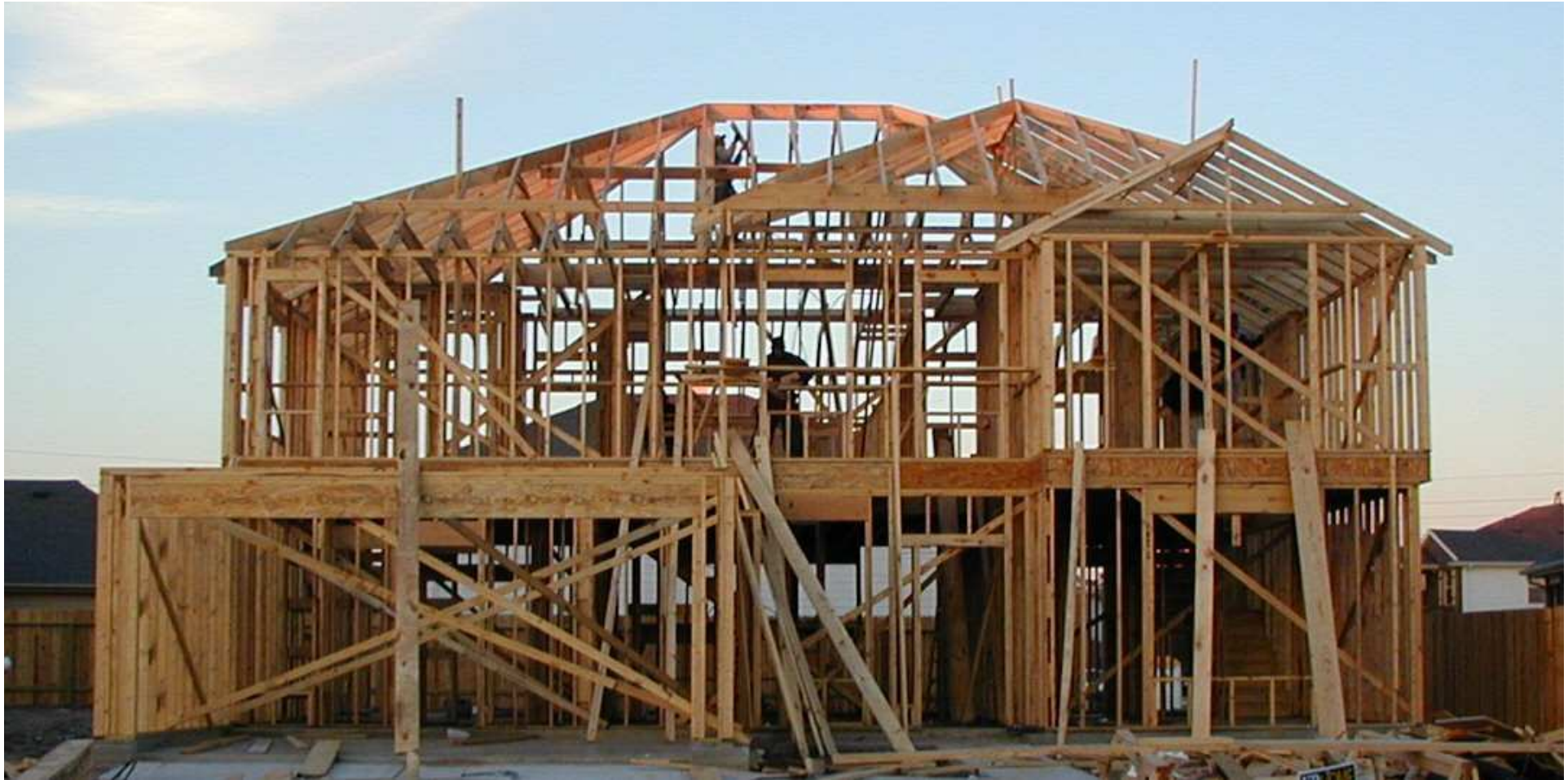
Casa a struttura "balloon frame"
