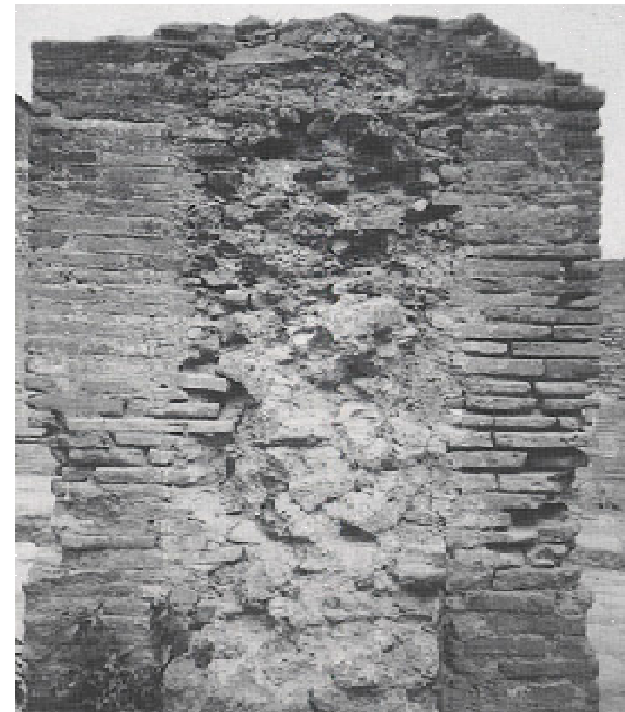
Muratura a sacco in mattoni e calcestruzzo
