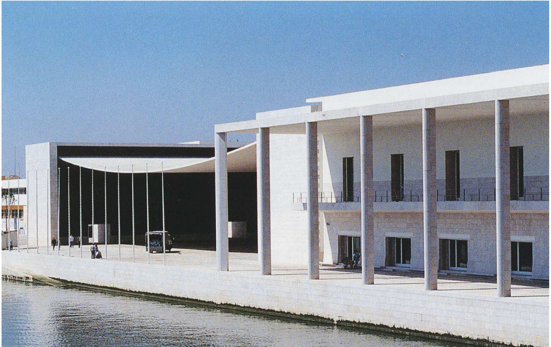
PADIGLIONE PORTOGHESE ALL'EXPO DI LISBONA - Alvaro Siza
