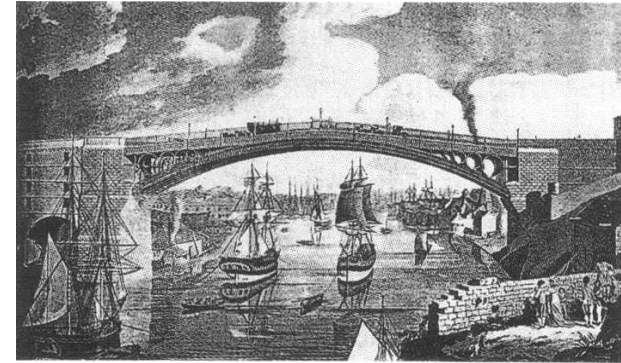
Ponte sul Wear di Sunderland, R. Burdon, 1793-96, L=72 m ghisa e ferro puddellato
