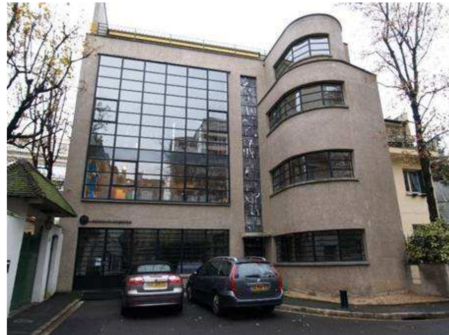
Casa e atelier-vetreria di Louis Barillet, 1931-32
