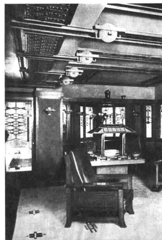
Il sistema di illuminazione sul soffitto del soggiorno.
