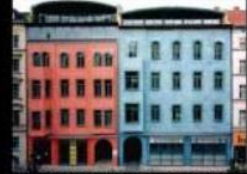
BERGAMANNSTRASSE - BERLINO Sopraelevazione di un piano all'edificio di 4 piani fuori terra, inserimento di ristoranti e negozi a piano terra e riprogettazione della facciata
