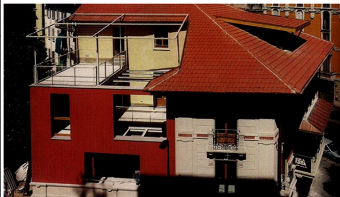
Addition Piazza Morbegno Milan
