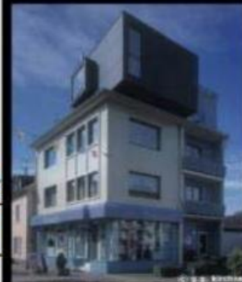
SIMBIONT - MERZIG Sopraelevazione di un edificio di tre piani fuori terra tramite più blocchi ad un piano
