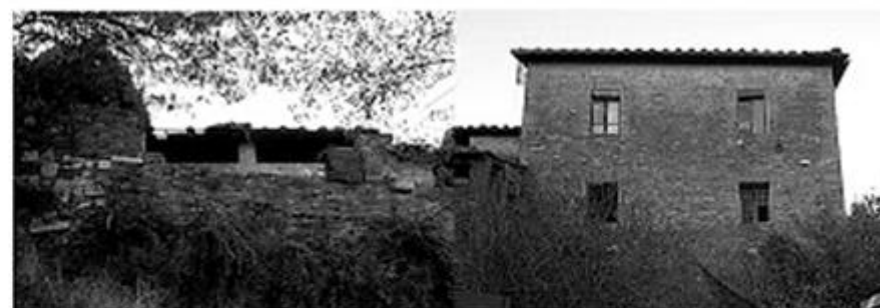
Foto significative dello stato di fatto
