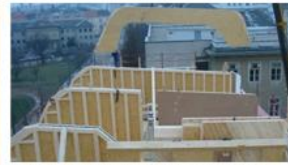
Immagini del montaggio della struttura (© unterlugger)
