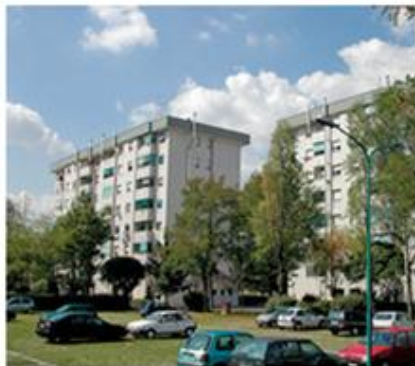
Foto significative dello stato di fatto
