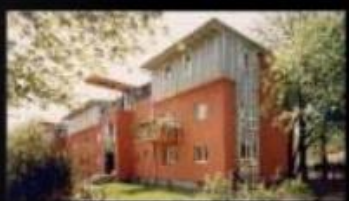
SCHLIERBACHER WEG - BERLINO Edificio Social housing sopraelevato tramite uso del prefabbricato (economicità), ampliamento dell'esistente, miglioramento della facciata e dell'isolamento
