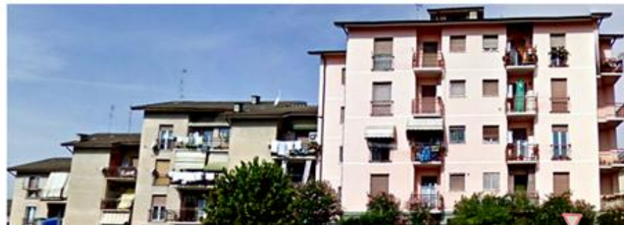
Foto significative dello stato di fatto
