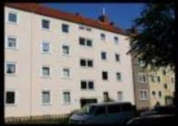
EULERSTRASSE - HANNOVER Ristrutturazione di tre edifici multipiano con coibentazione delle pareti, inserimento di impianto solare, sostituzione della caldaia e serramenti
