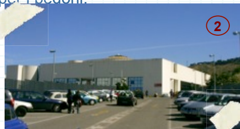
Entrata alla Facoltà di Architettura Pedoni costretti a muoversi in uno spazio limitato, facendosi largo tra le macchine in movimento e quelle parcheggiate nei posteggi.
