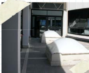
Terrazzo scoperto. Particolare dei lucernari esistenti
