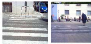
Fig 1 Esempio di attraversamento colpito dalla presenza dei dislivelli del traffico. Fig 2 Assenza di scivolo sul marciapiede opposto in corrispondenza delle attraversamenti pedonali. Il fondo stradale, in presenza di alti attraversamenti stradali, pone come difficoltà nel marciapiede scivolare per la necessità di scendere la velocità (D.M. 276/89).
