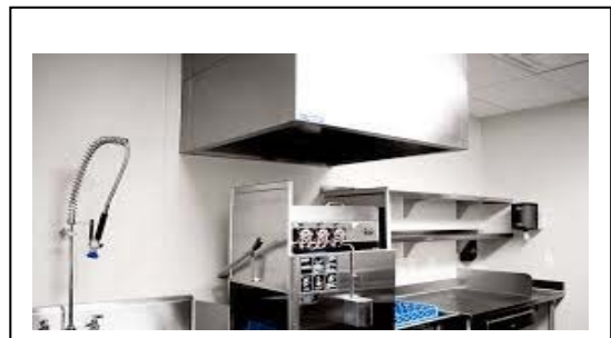
Cappa di condensa tipo II nell'area della lavastoviglie.
